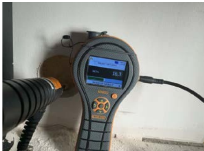
Hulltaking - Fuktmåling - Tørr konstruksjon i hulltakingsområdet.
