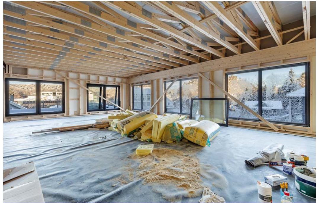
Lokaler 3.etg. Blir innredet etter ønsker fra leietager.
