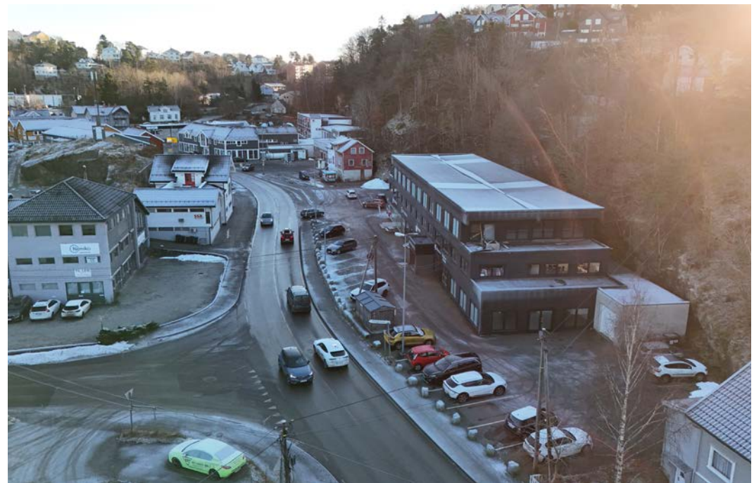
Oversiktsbilde av bygget med god profilering fra hovedveien.
