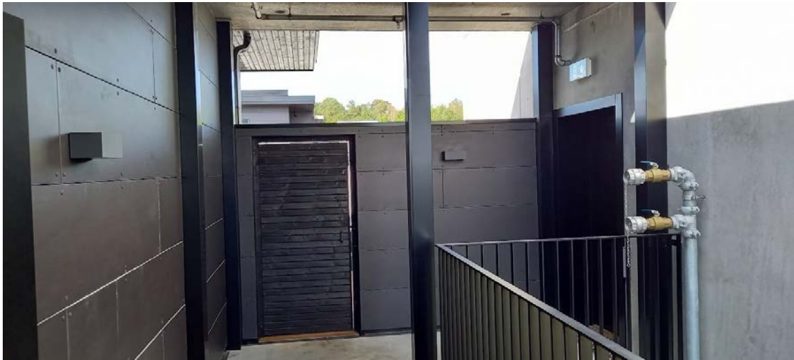
Utvendig dør til altan i blokk 12
