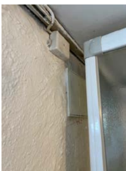
Ventil var lukket på befaringstidspunktet
