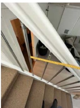
Manglende håndløper på deler av trapp
