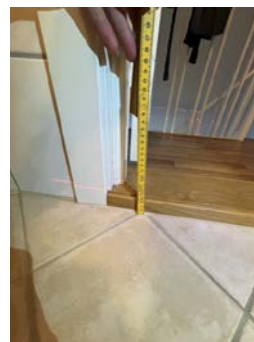
9mm fra foran dusjkabinett til topp flis foran dør
