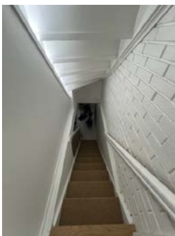
Manglende håndløper på deler av trapp
