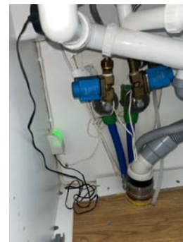
Lekkasjedeteksjon og vannstopper
