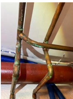
Tilkoblingspunkt rør-i-rør og stoppekran til utevann
