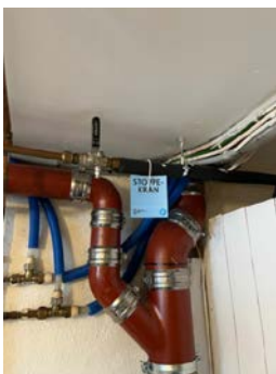
Tilkoblingspunkt rør-i-rør og stoppekran til utevann
