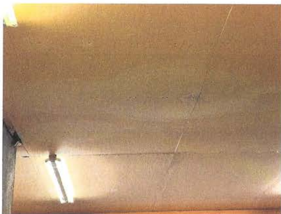
Lekkasjemerker i gipshimling på loft og på leca pipe.
