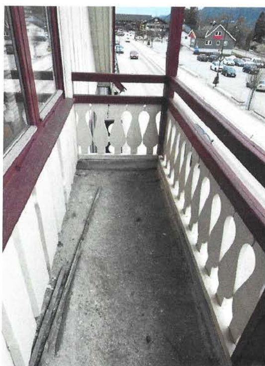
Veranda mot gate.
