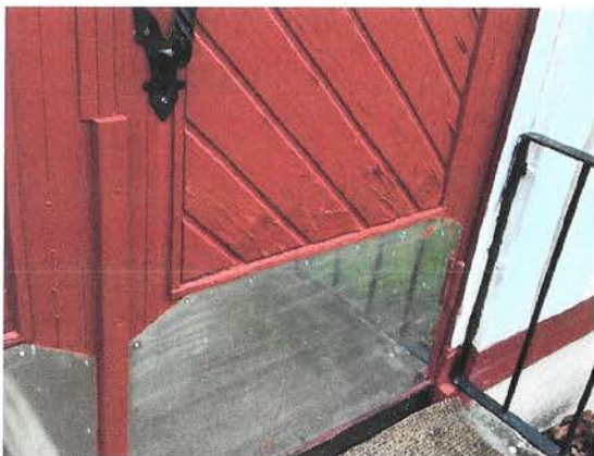
Dobbel dør mot bakside fra 2. etg som har dårlig panel på utsiden.
