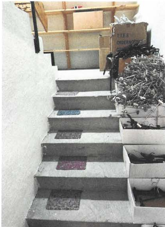
Støpt trapp ti loft.
