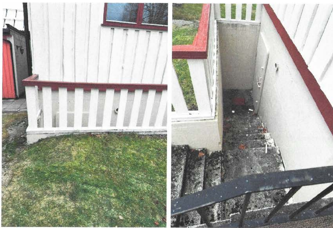
Rekkverk på topp av trapp og trapp ned til 1. etg fra bakside
