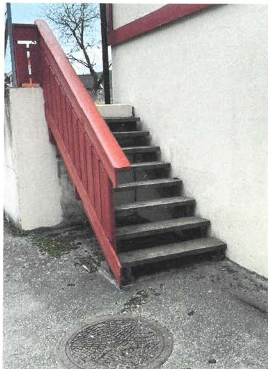
Trapp til bakside av bygg.
