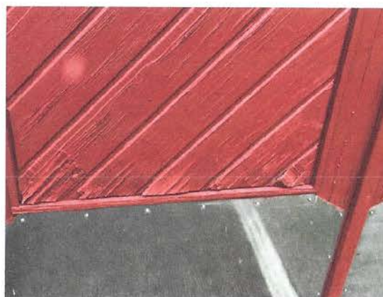
Dobbel dør mot bakside fra 2. etg som har dårlig panel på utsiden.
