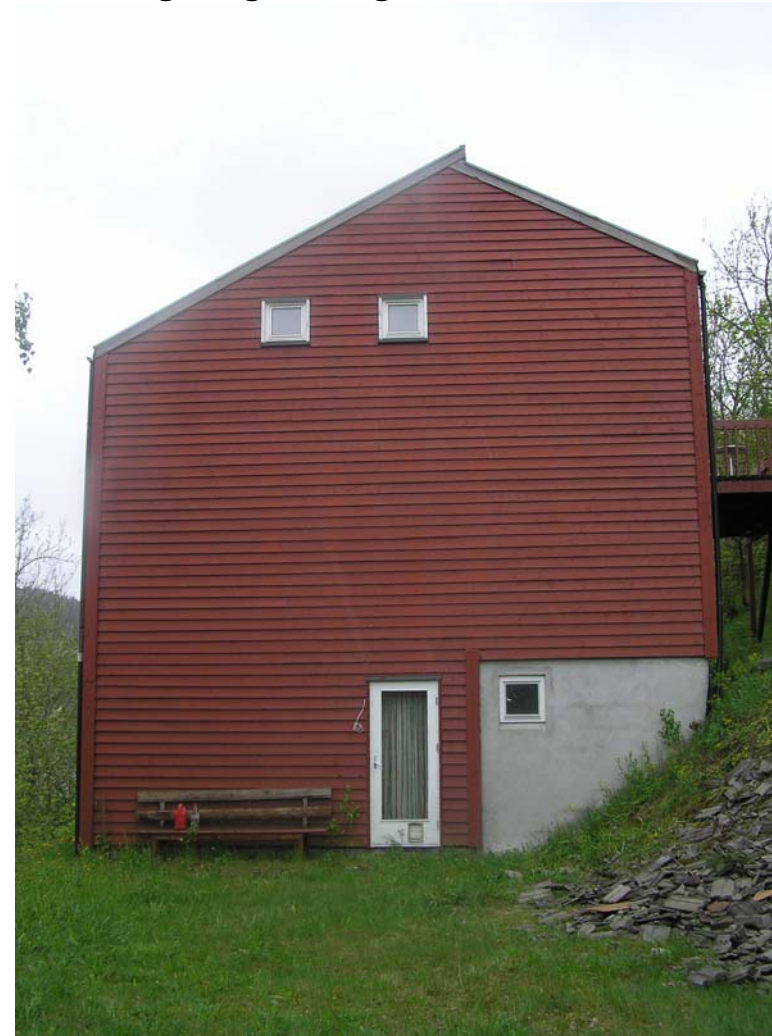
Utgang 1.etg. sett fra nord-øst
