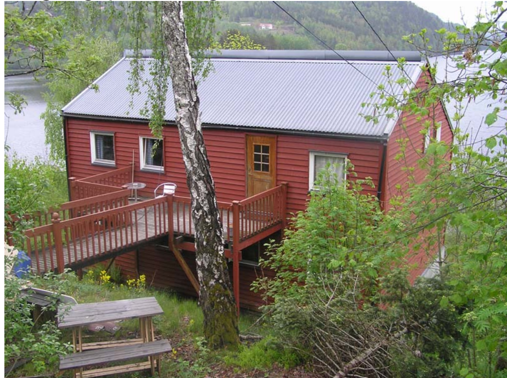
Inngangsparti 3.etg. sett fra vest
