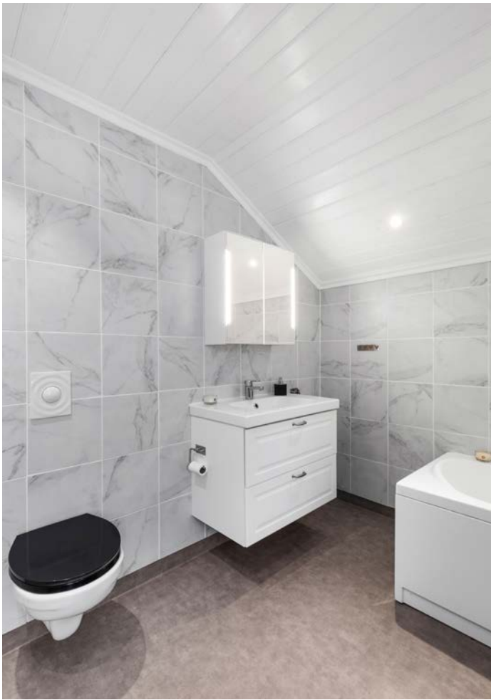
Vegghengt wc og servant
