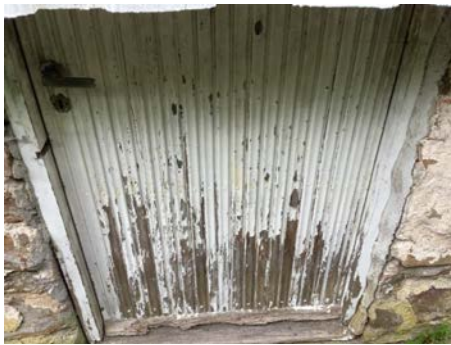
Enkel dør i grunnmuren.
