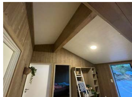
Utsnitt gjenbygd takkonstruksjon.
