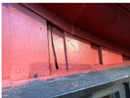
Ingen lufting bak kledning.
