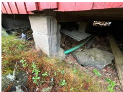
Betongstein som ringmur. Enkelte sprekker.
