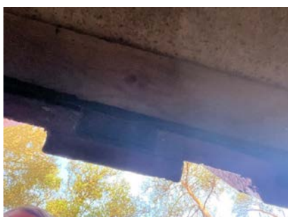
Ingen lufting bak kledning.
