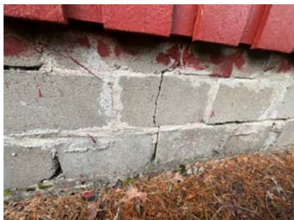
Betongstein som ringmur. Enkelte sprekker.
