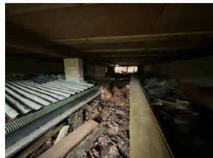
Søylepunkter under midten av boligen.
