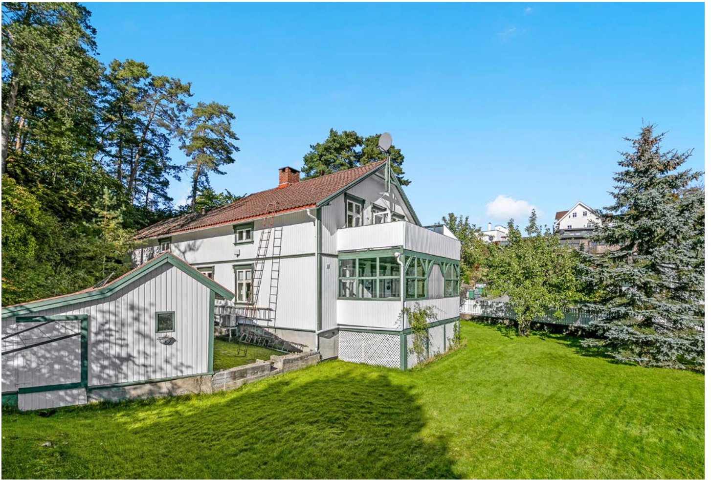
På tomten er det oppført frittstående bod
