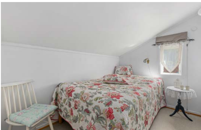
Rom benyttet som soverom (ikke tilfredsstillende rømningsvei)
