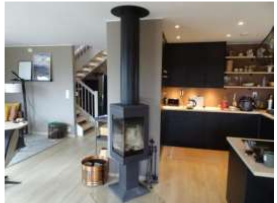
Ildsted tilsluttet stålpipen
