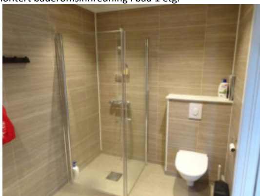
dusjvegger, veggmontert wc
