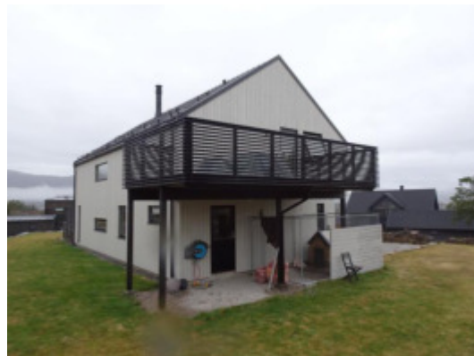
Altan på søndre side av bygget
