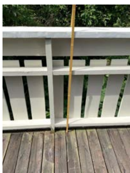
Rekkverk er lavere enn dagens krav
