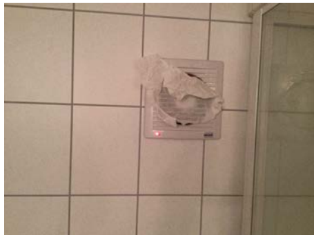
Avtrekk okrommet mangler tilluft
