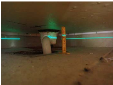
Måling ved sluk under kabinett
