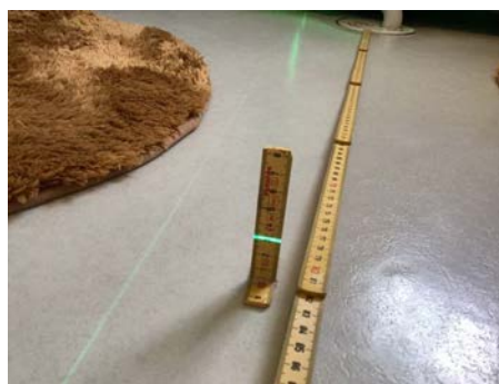
Måling 80 cm fra sluk.
