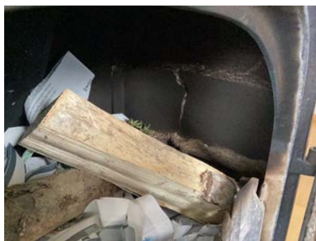
Sprekk på plate i ovn.
