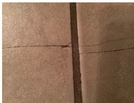
Sprekk i 4 fliser.
