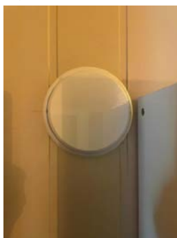
Avtrekk okrommet mangler tilluft
