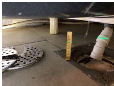
Måling ved sluk
