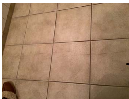
Sprekk i 4 fliser.
