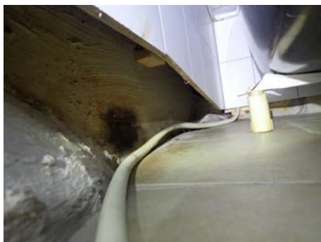
Åpninger bak plater
