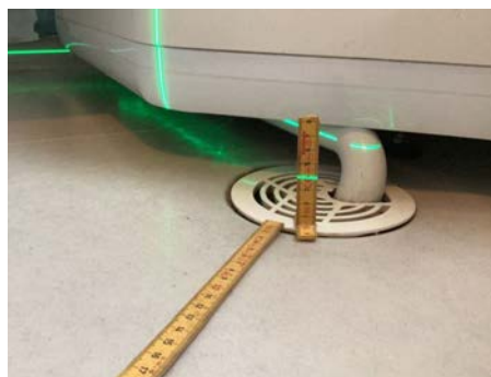
Måling ved sluk
