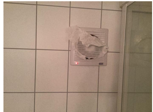
Avtrekk okrommet mangler tilluft
