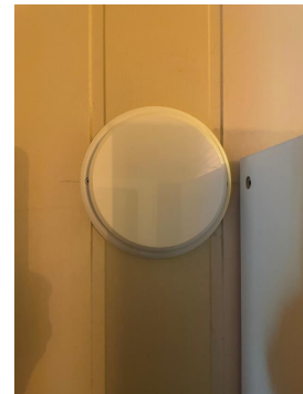
Avtrekk okrommet mangler tilluft
