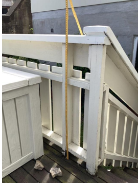
Rekkverk er lavere en dagens krav
