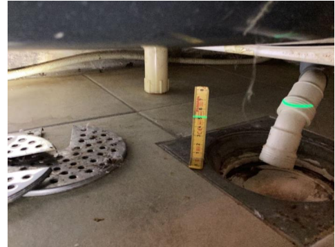
Måling ved sluk
