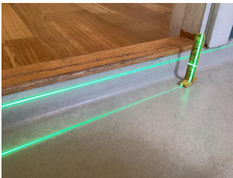
Måling ved terskel.
