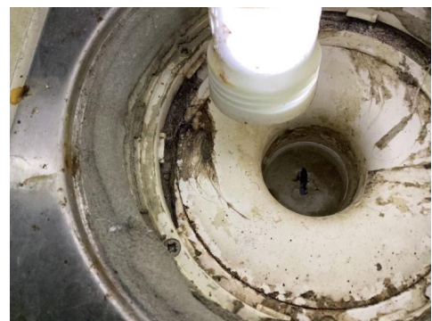
Membran påvist under klemring i sluk under badekar
