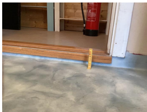
Måling ved terskel 2
