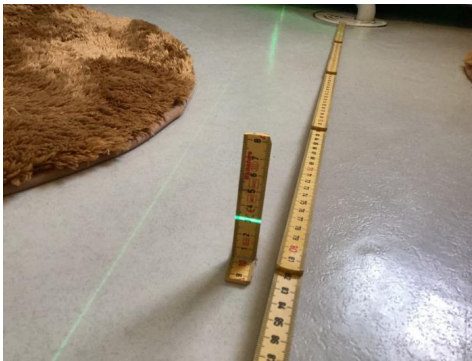
Måling 80 cm fra sluk.
