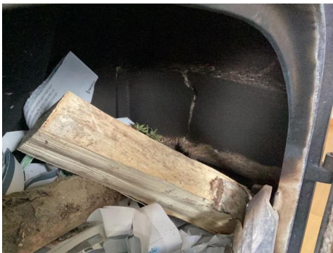
Sprekk på plate i ovn.
