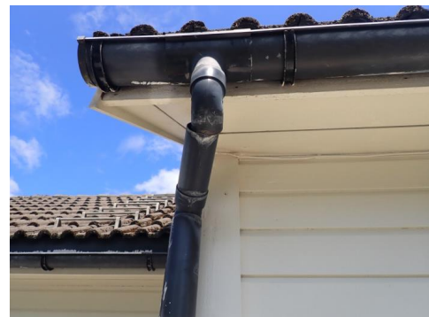
Utett i overgang på nedløp.
