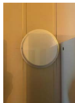
Avtrekk okrommet mangler tilluft
