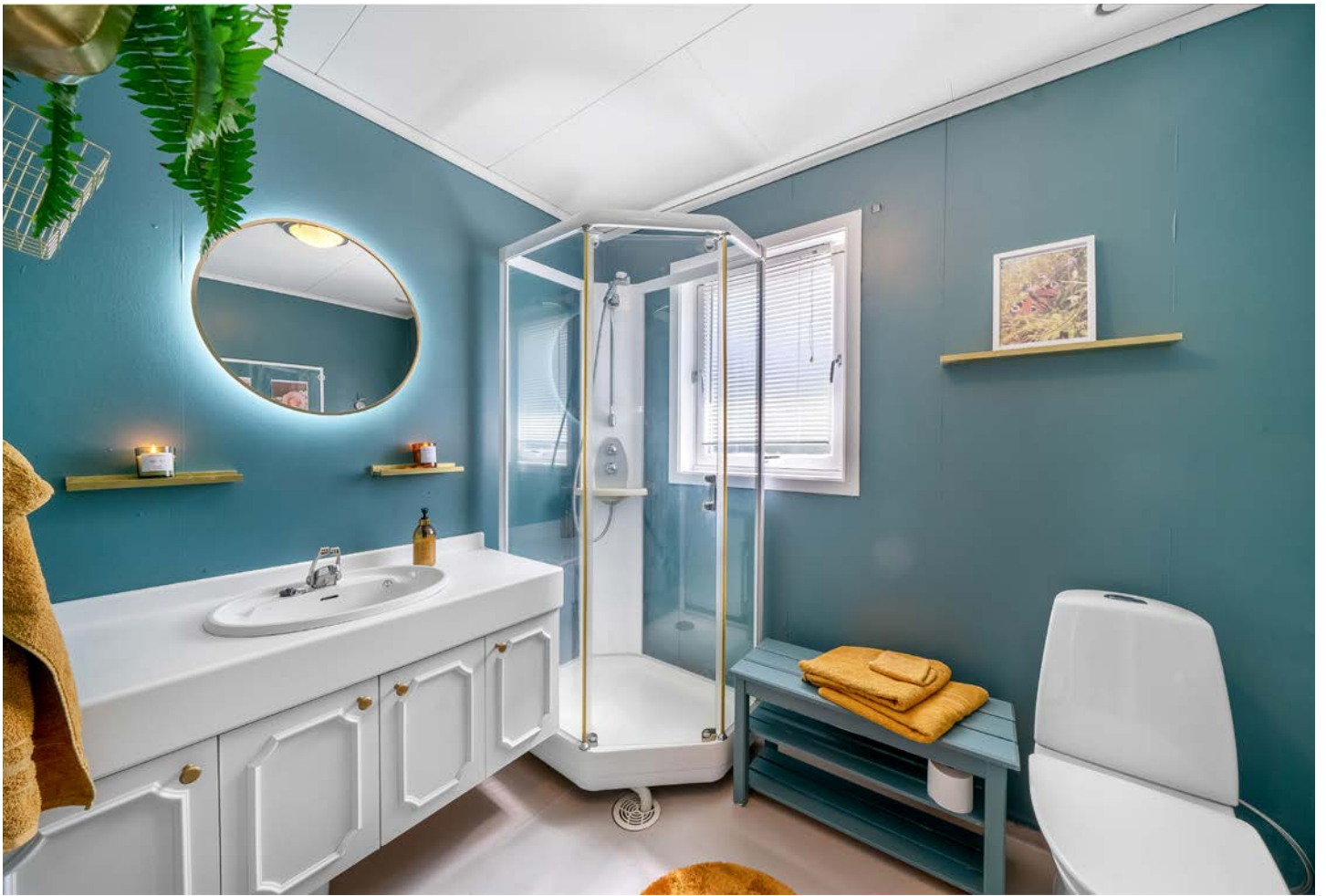
Pent bad beliggende på øverste plan med belegg på gulv og malte veggflater. Badet er innredet med baderomsinnredning, toalett og dusjkabinett.
