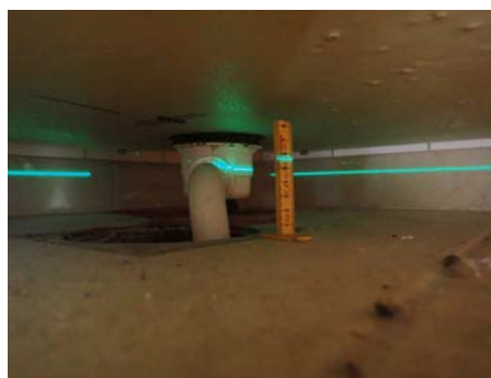
Måling ved sluk under kabinett
