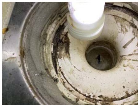
Membran påvist under klemring i sluk under badekar
