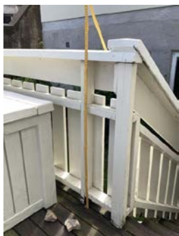
Rekkverk er lavere en dagens krav
