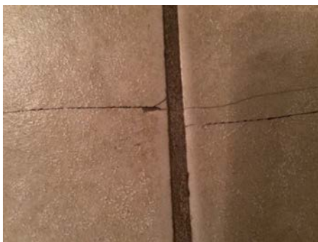
Sprekk i 4 fliser.
