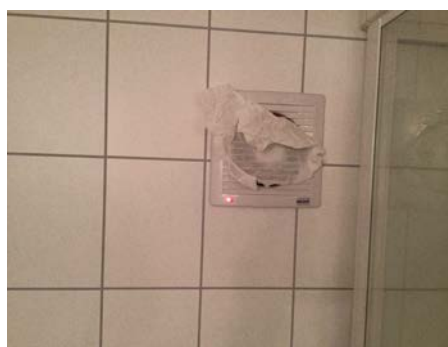
Avtrekk okrommet mangler tilluft
