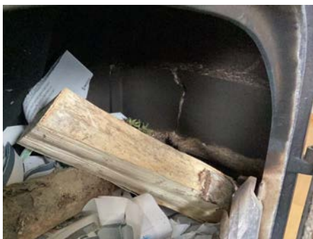
Sprekk på plate i ovn.
