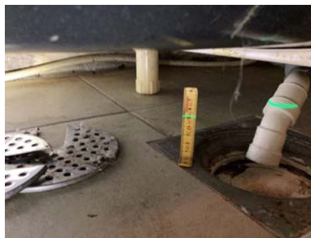
Måling ved sluk
