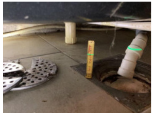
Måling ved sluk
