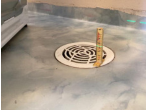
Måling til sluk ved kabinett
