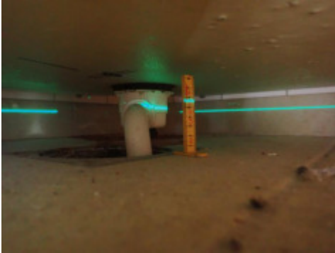
Måling ved sluk under kabinett
