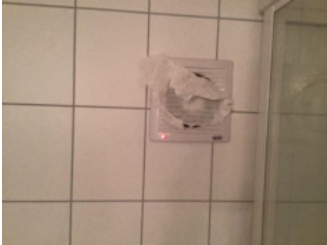
Avtrekk okrommet mangler tilluft
