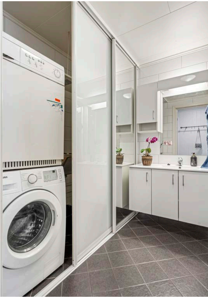
Opplegg til vaskemaskin på badet
