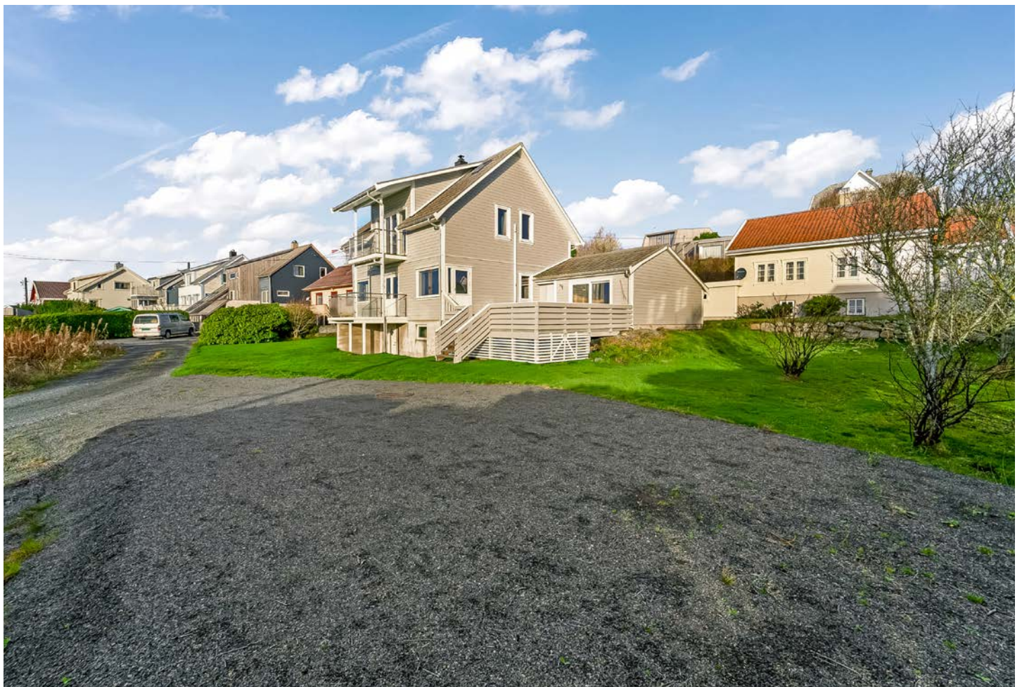
Gruslagt område gjort klart til fremtidig garasje. Kjøper må evt. søke byggeskjønnelse.
