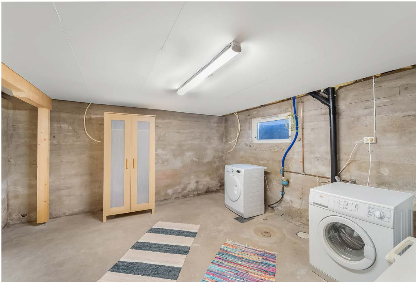
Vaskerom er etablert i kjelleren.
