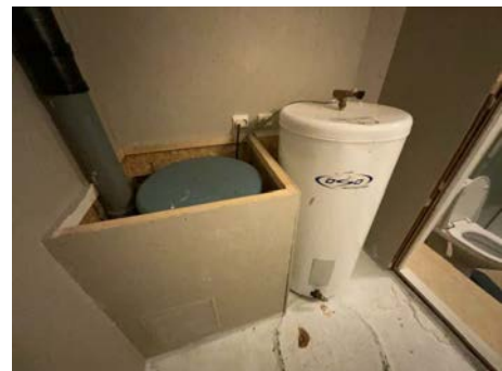
Varmtvannstank.
