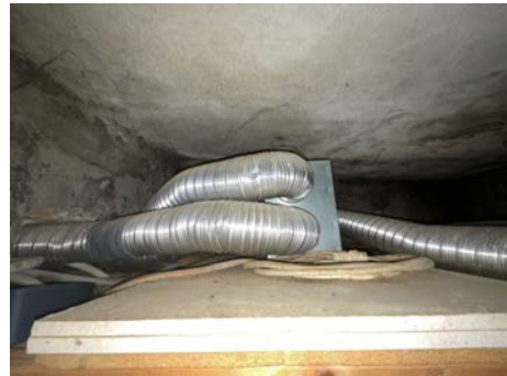
Utsnitt mekanisk avtrekk.
