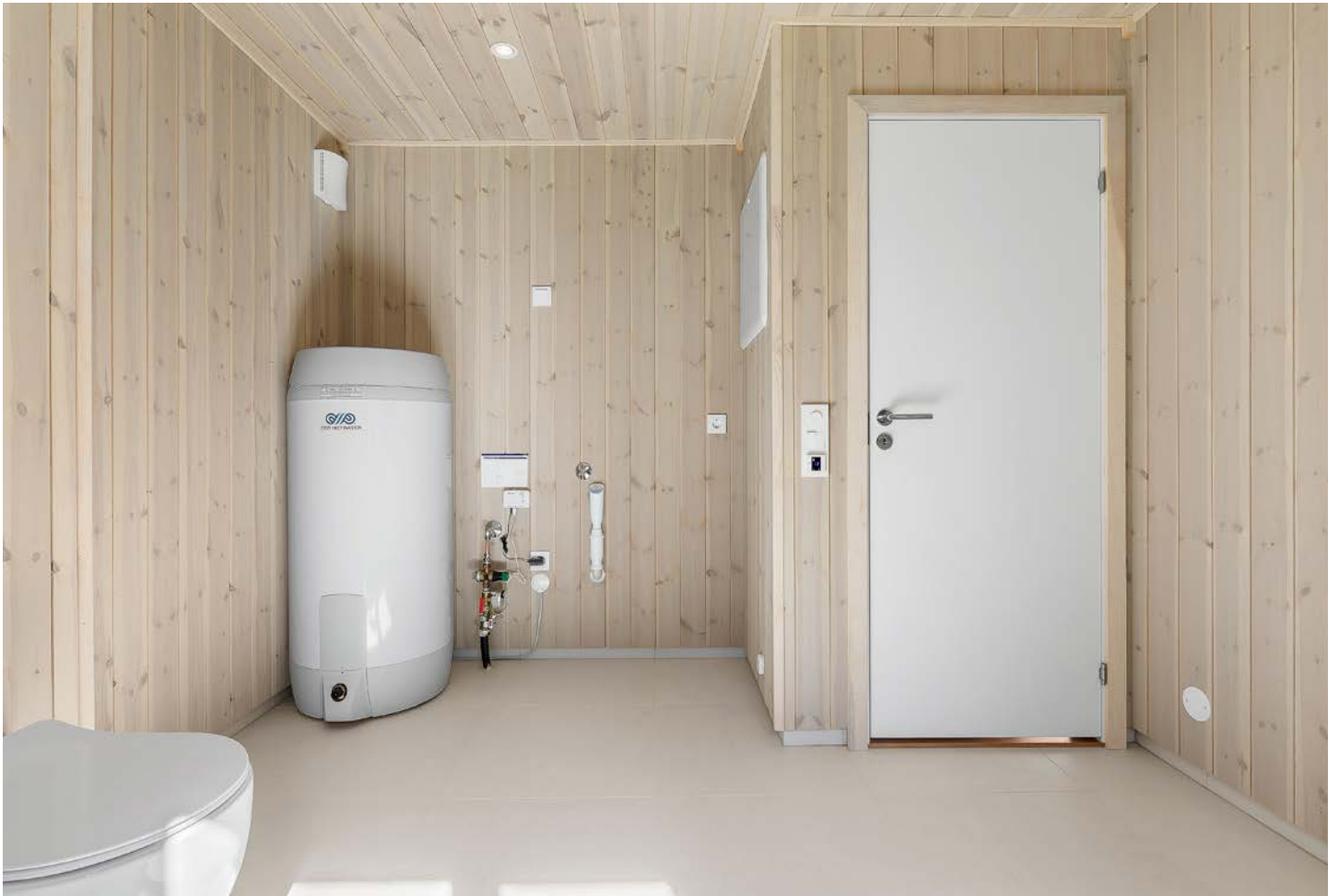
Del av badet hvor varmtvannsberederen er plassert. Avsatt plass-/opplegg til vaskemaskin.
