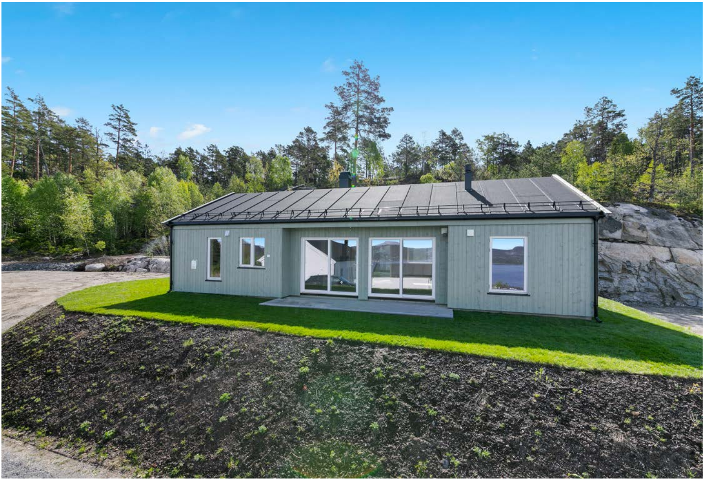
Fasade med fin uteplass i front. Det er også terrasseplattning i bakkant av hytta. Ny ferdigplen i 2024.
