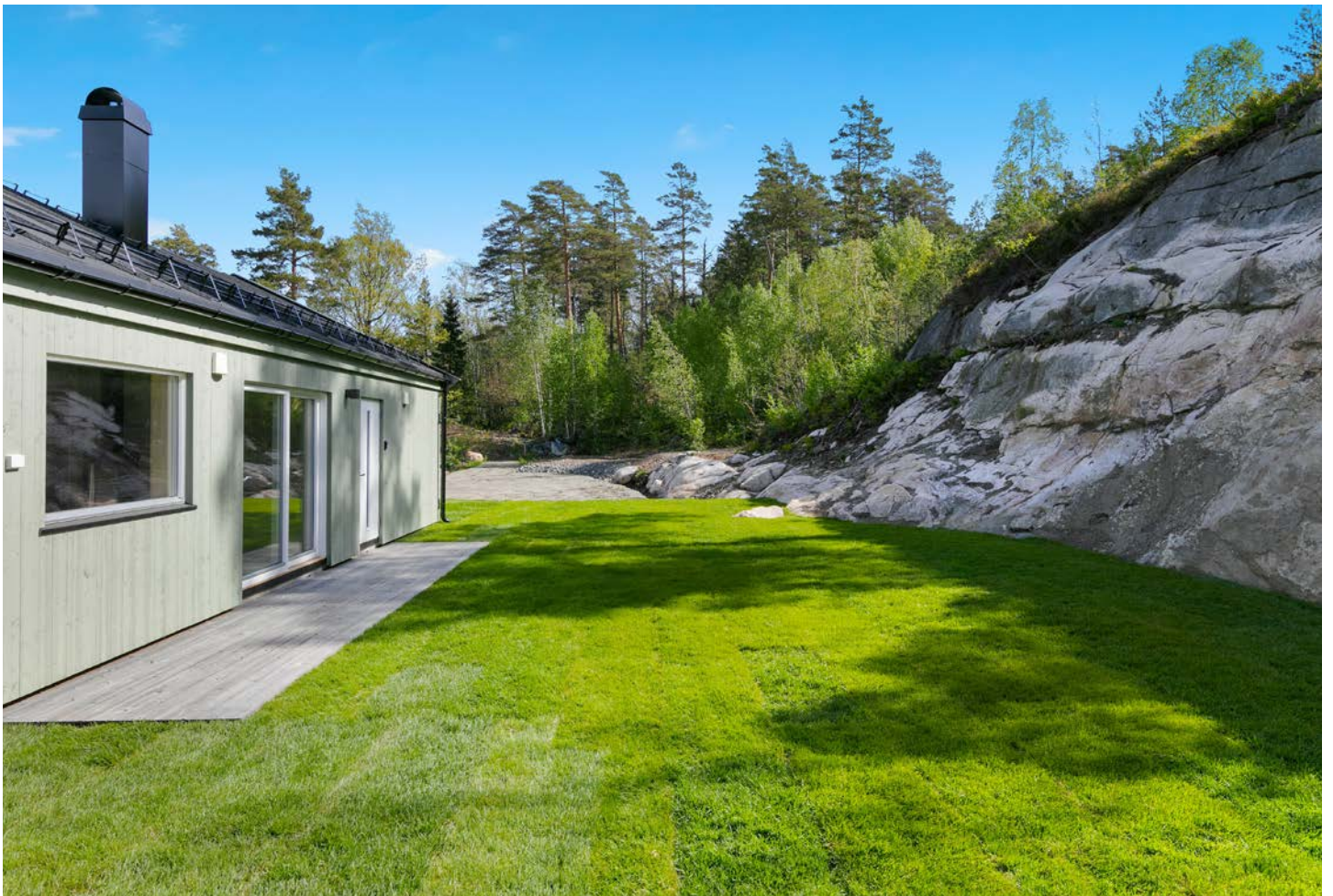
Terrasseplattning ved inngangspartiet
