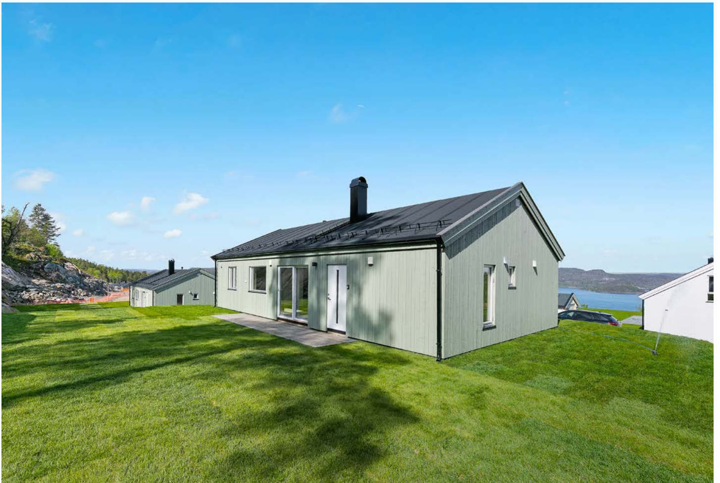
fasade med inngangspartiet. Også her en terrasseplattning med et usjenert uteareal
