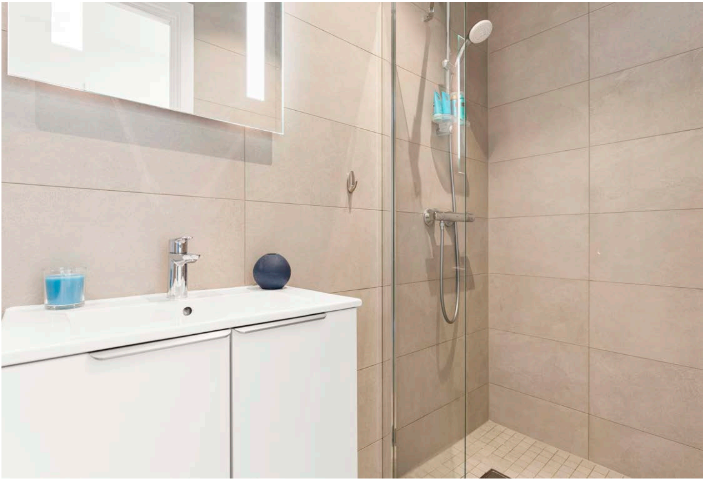
Bad med varmekabler
