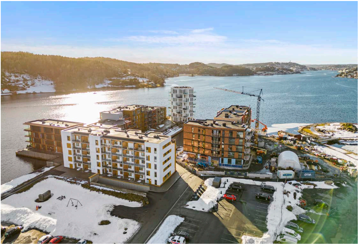
Bryggebyen består av flere boligblokker oppført ifra 4 til 8 etasjer.
