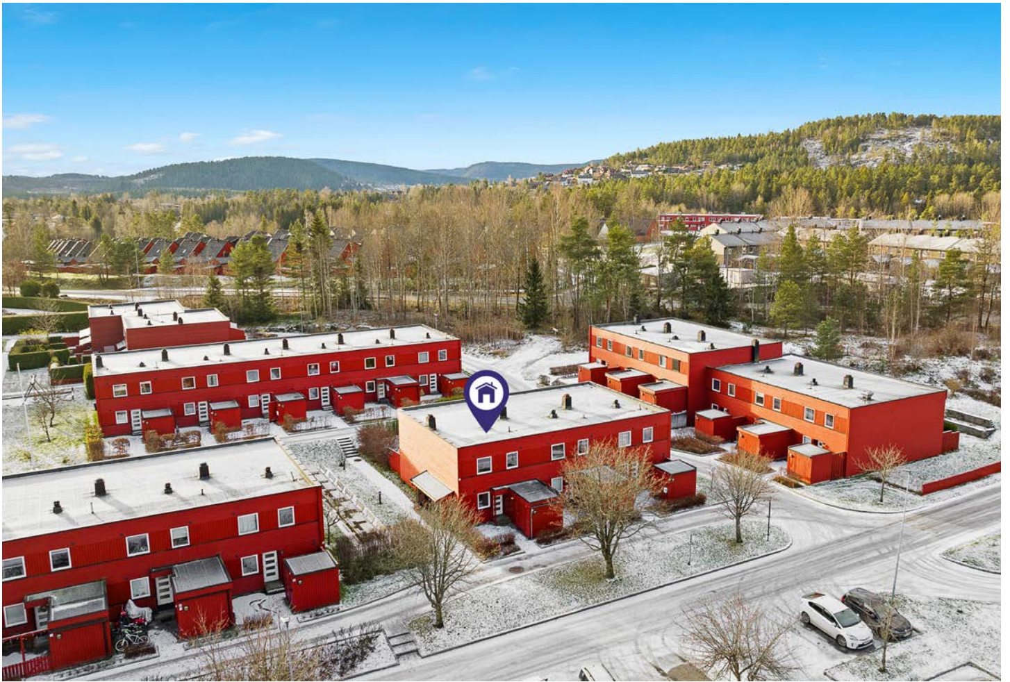
Boligen har en god beliggenhet og planløsning, med blant annet to bad og tre soverom
