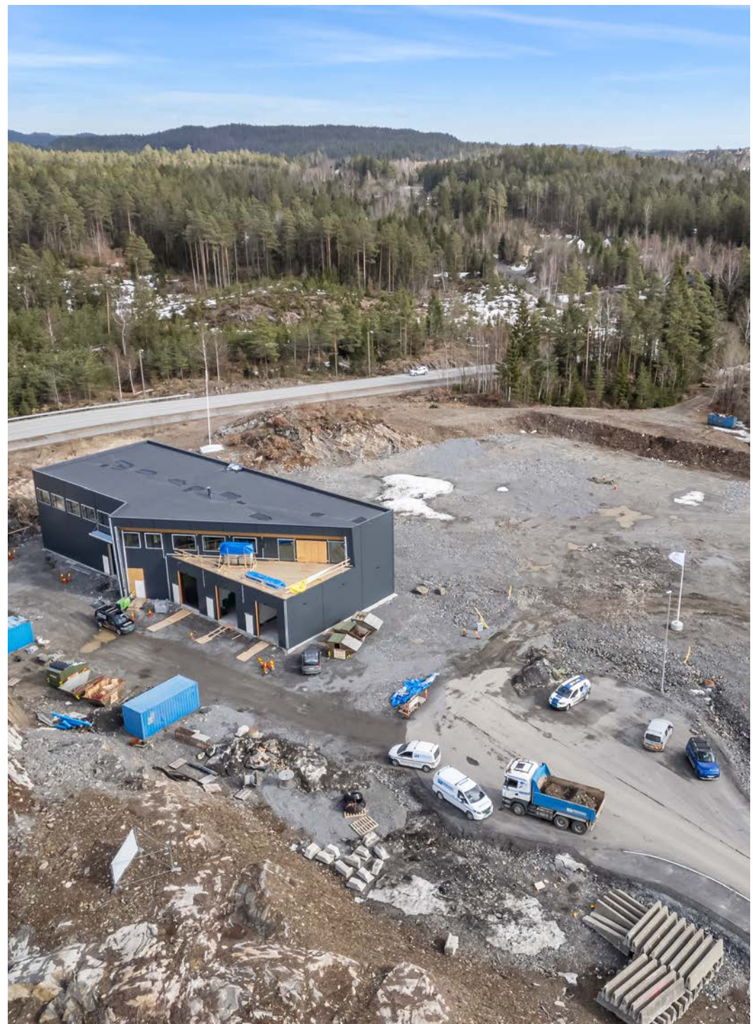
Oversiktskart hvor Neding elektro er i ferd med å ferdigstille bygg på nabotomt.
