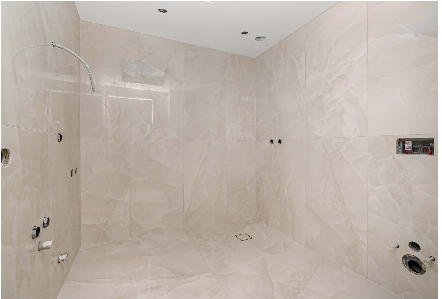
Bad under opparbeidelse - lekkert flisvalg
