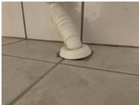
Rørgjennomføring i gulv.
