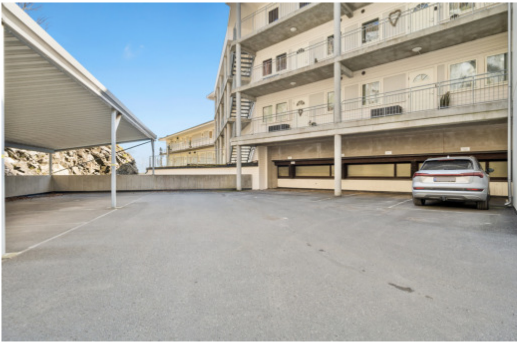
Lokkebakken 12 - 21 - utvendig parkering
