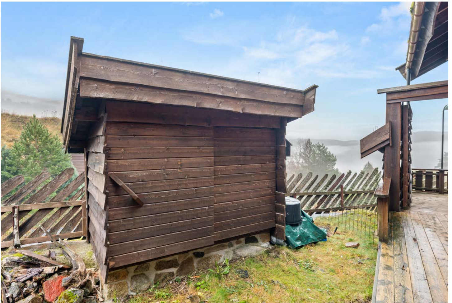
Vedbod (ikke omsøkt) ved inngangspartiet
