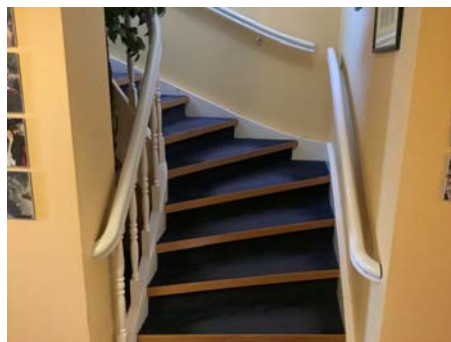
Trapp fra 1. etasje til underetasje.
