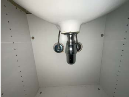
Del av rør til avløp.
