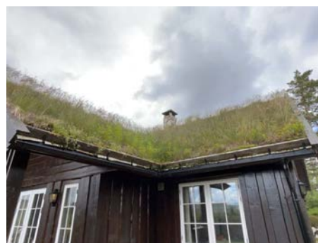
Del av taktekkning.
