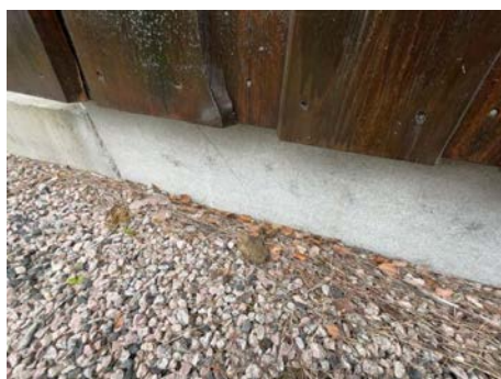
Del av grunnmur.
