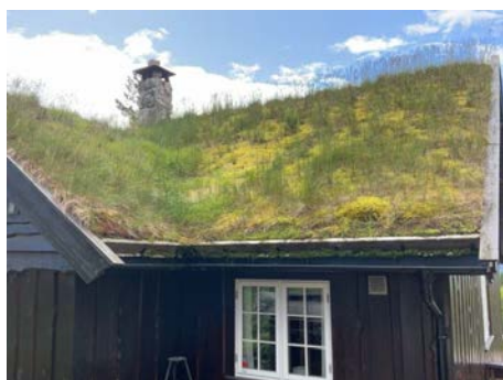
Del av taktekkning.
