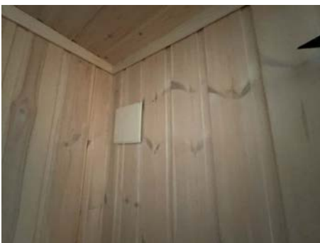
Eksempel på montert ventil i vegg.
