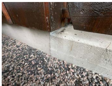
Del av grunnmur.
