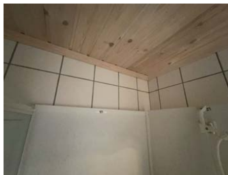
Del av vegg - tak.
