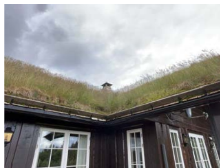
Del av taktekkning.
