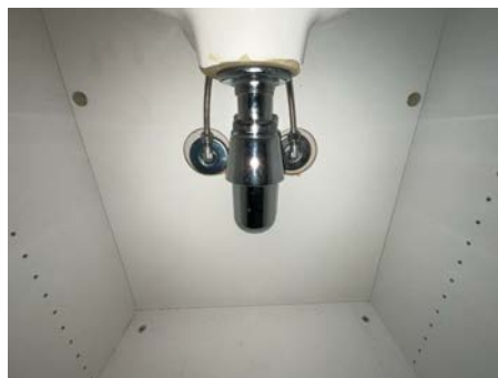
Del av rør til vann.
