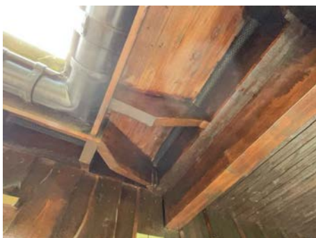
Del av takkonstruksjon.
