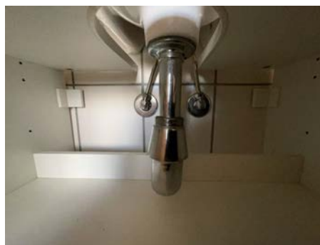
Del av rør til vann.
