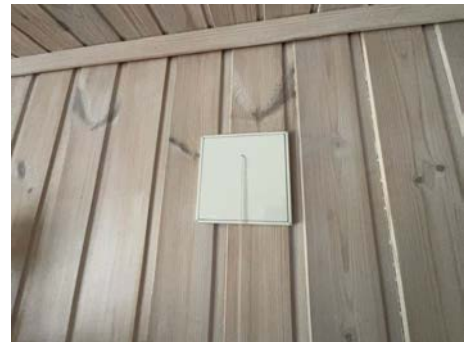
Eksempel på montert ventil i vegg.
