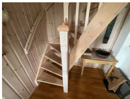
Trapp opp til 2 etasje.
