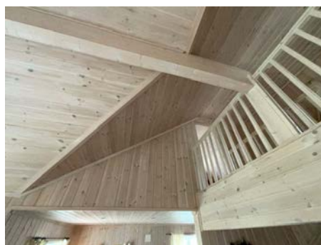
Del av vegg - tak.
