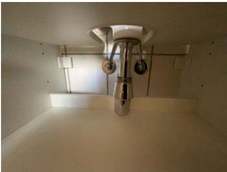
Del av rør til avløp.
