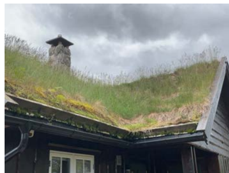
Del av taktekkning.
