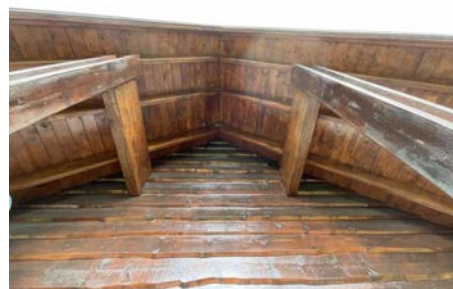
Del av takkonstruksjon.
