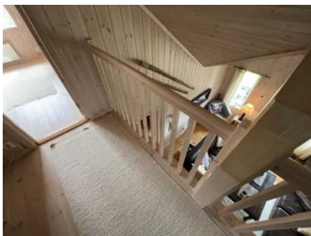
Rekkverk i 2 etasje.
