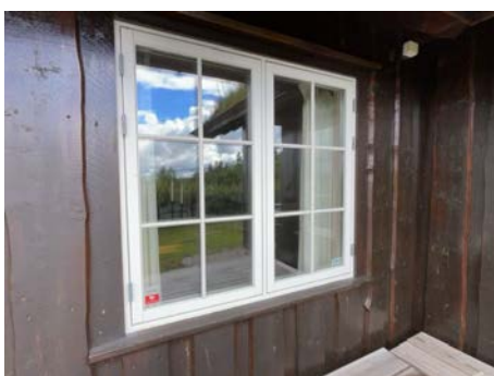
Eksempel på vindu i yttervegg.
