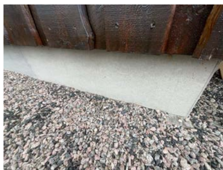
Del av grunnmur.
