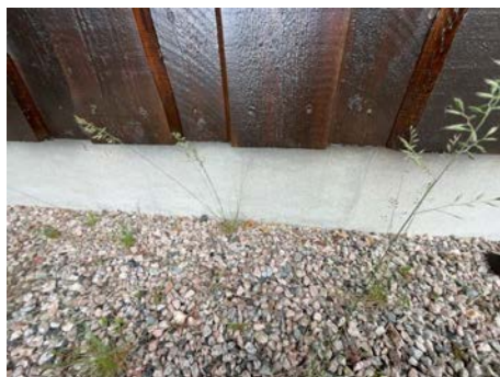
Del av grunnmur.
