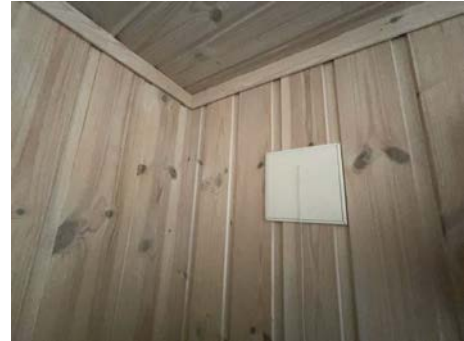
Eksempel på montert ventil i vegg.
