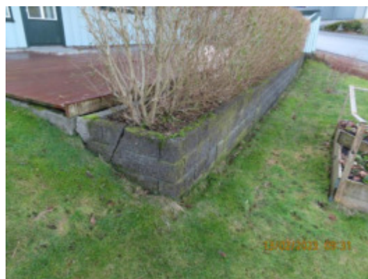
Hagemur på nedside av bolig
