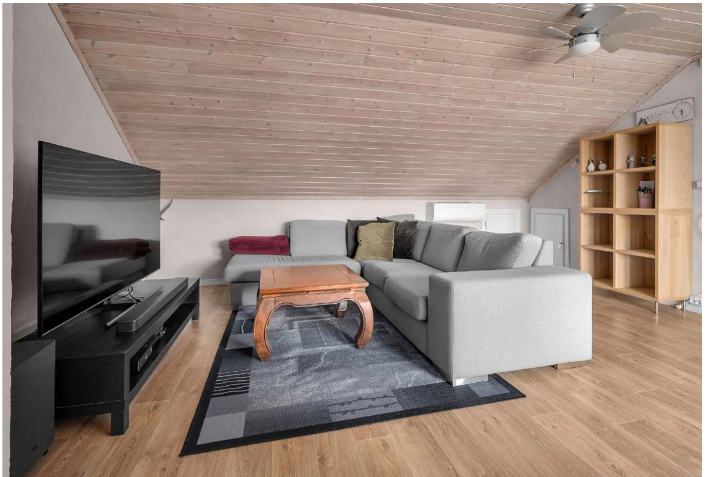
I loftstuen er det også montert varmepumpe.
