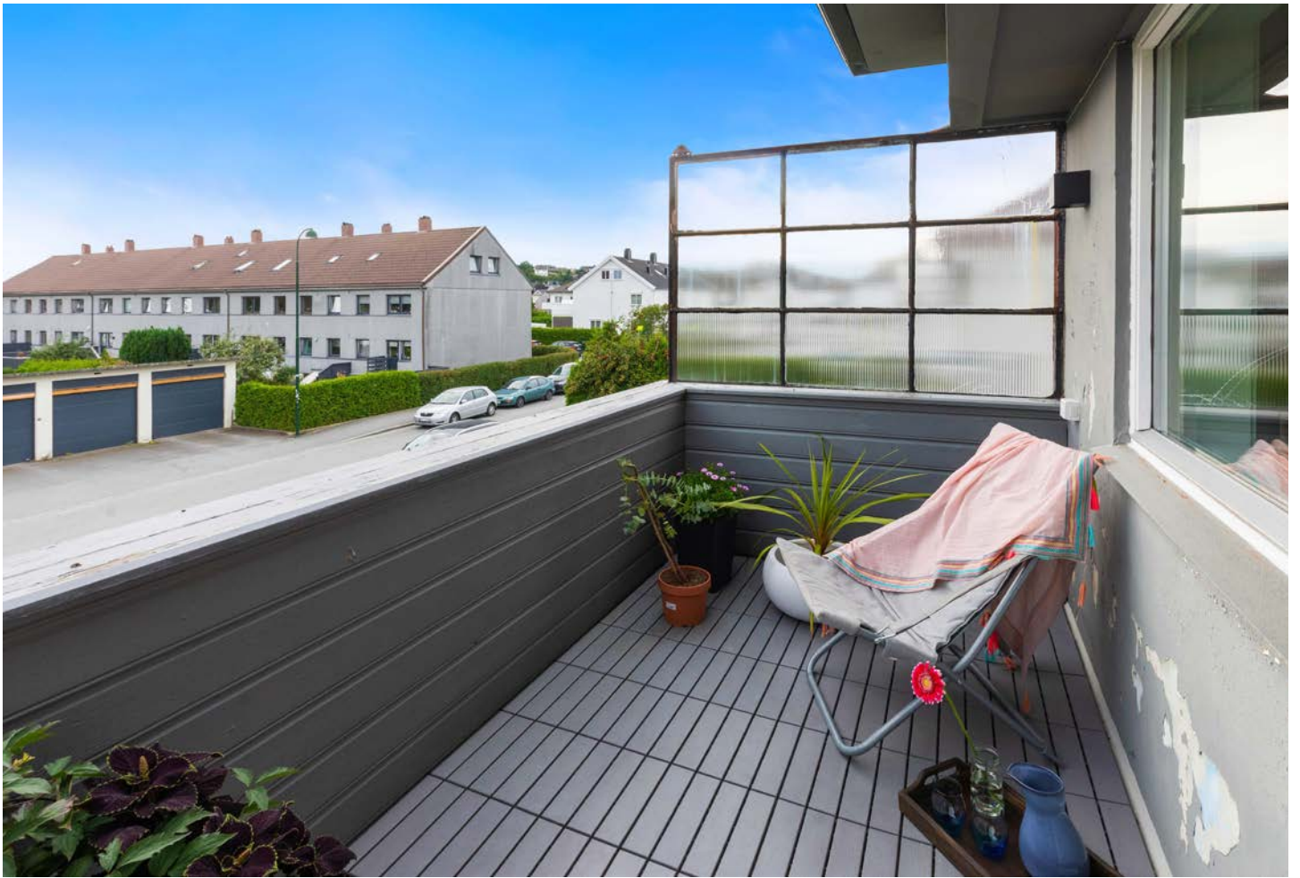
Solrik balkong med plass til utemøbler
