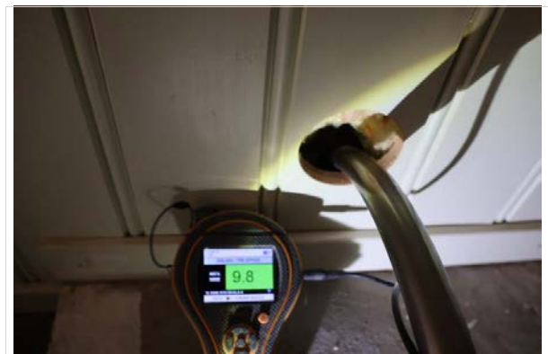
Det ble boret hull i tilstøtende rom. Ingen fukt.
