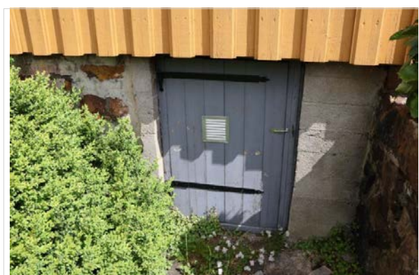
Krypkjeller under deler av bygget.
