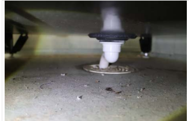
Belegg på gulvet er klemt i sluket.
