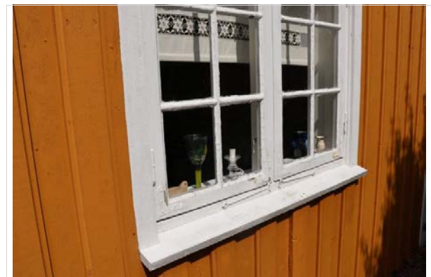
Eldre vinduer med 1. glass.
