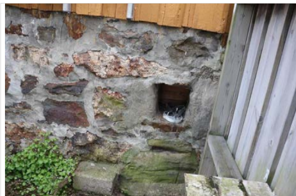
Grunnmur av stein og sement. Vinduene er av tre med ... lags glass fra ...
