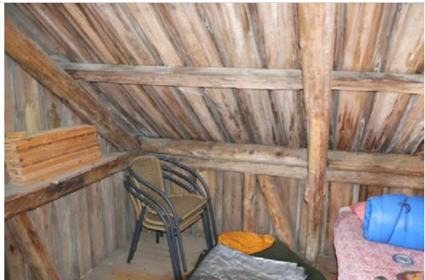
Takkonstruksjon av bord, sperrer og åser.
