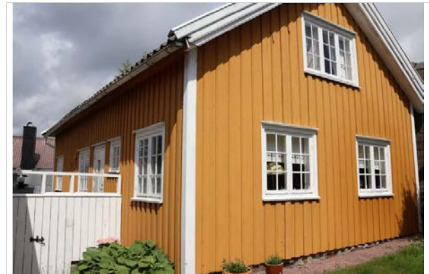
Kledning i tre utenpå stokker.
