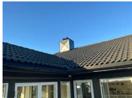
Beslått pipe. Gradrenner med beslag.
