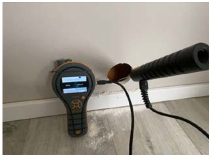
Hulltaking - Fuktmåling - Tørr konstruksjon i hulltakingsområdet.
