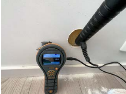
Hulltaking - Fuktmåling - Tørr konstruksjon i hulltakingsområdet.
