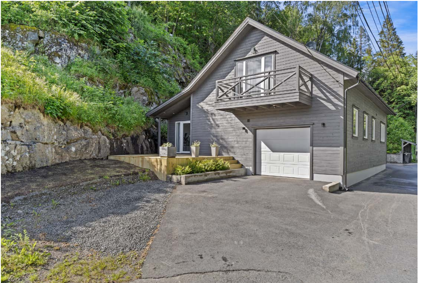
Det er utgang til en liten balkong fra loftstue
