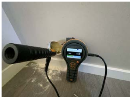
Hulltaking - Fuktmåling - Tørr konstruksjon i hulltakingsområdet.
