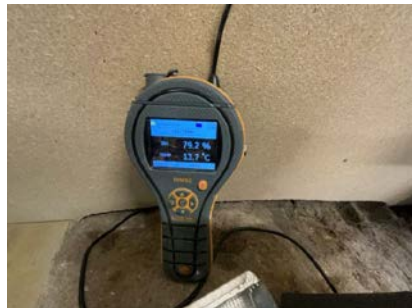
Kryprom - Fuktmåling - Høy relativ luftfuktighet.
