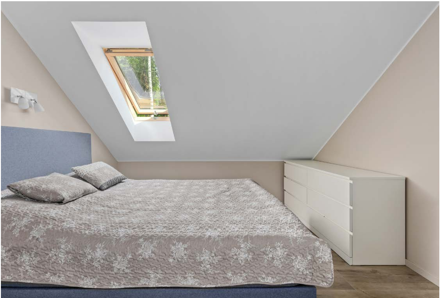
Rom benyttet som soverom (ikke tilfredsstillende rømningsvei)
