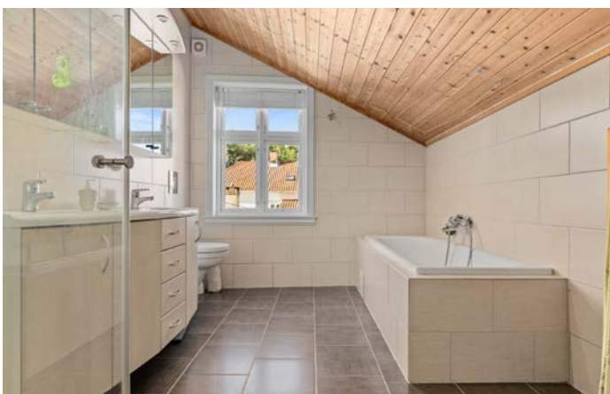
Eier opplyser om at badet er oppgradert i 2008 og at vaskerommet i hovedetasjen er tilbygg fra 2008
