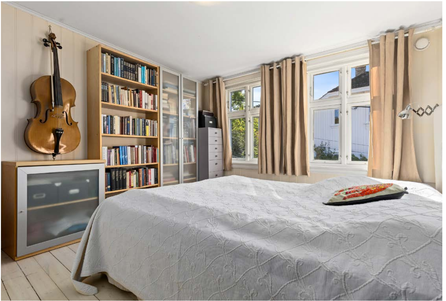
Rom benyttet som soverom. Vindu tilfredsstiller ikke dagens krav til rømningsvei
