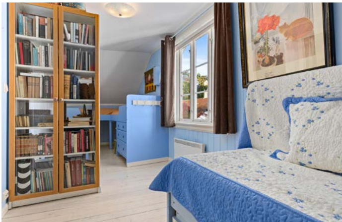
Rom benyttet som soverom. Vindu tilfredsstiller ikke dagens krav til rømningsvei. Rommet er delt opp i to soner med plassbygde senger
