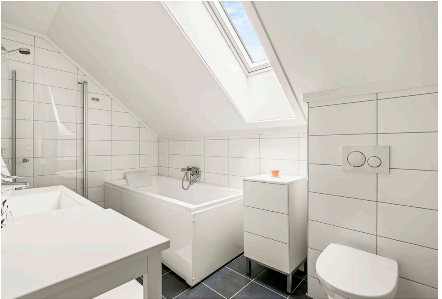
Bad i 2. etg som er flislagt på gulv og vegger, og med varmekabler i gulv.
