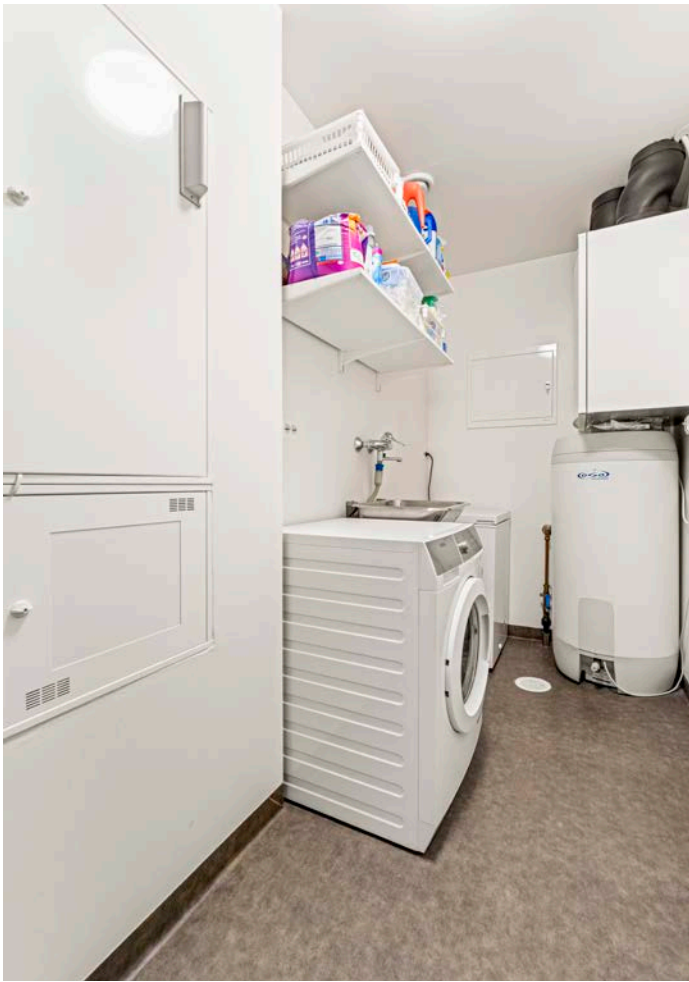
Vaskerom i 1. etg.
