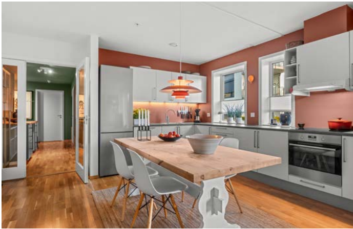
Vannbåren varme i stue/kjøkken og gang.
