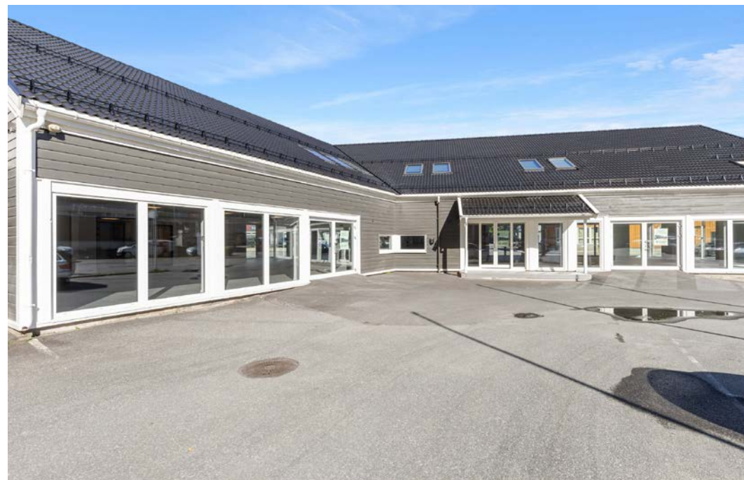
Butikk/utstillingslokalene er helt nyoppusset og er på 617 m 2 + verksted.
