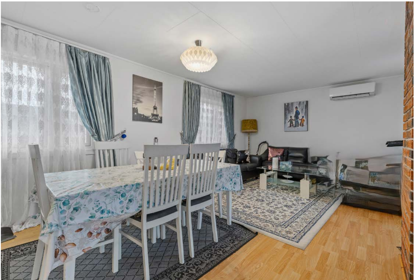
Det er montert varmepumpe i stue i hoveddel
