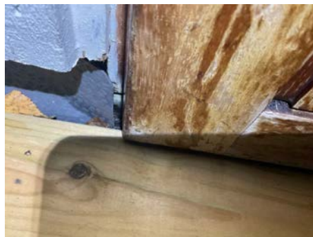
Bilde viser membranoppkant ved balkongdør
