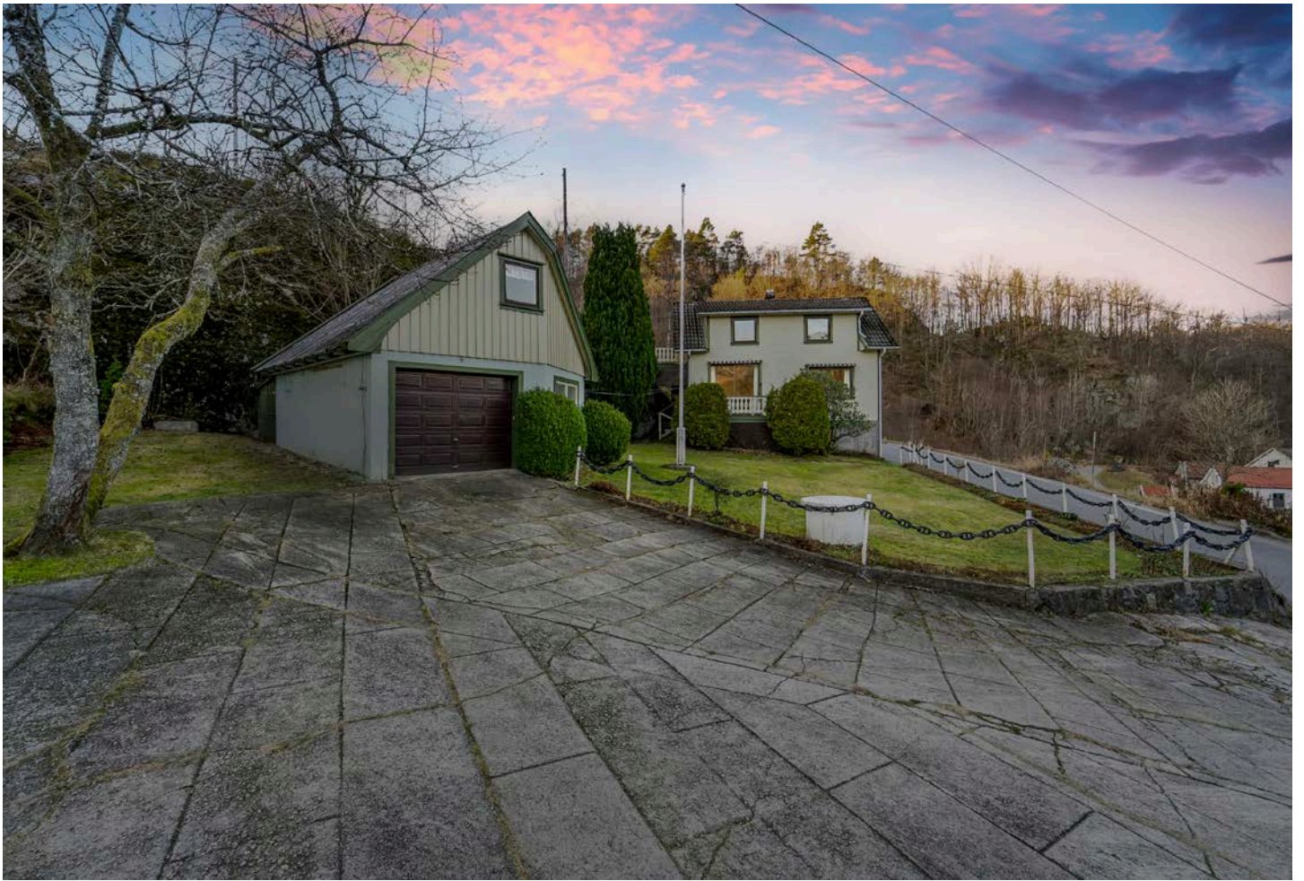
Støpt betong på p-plass og mot garasje.
