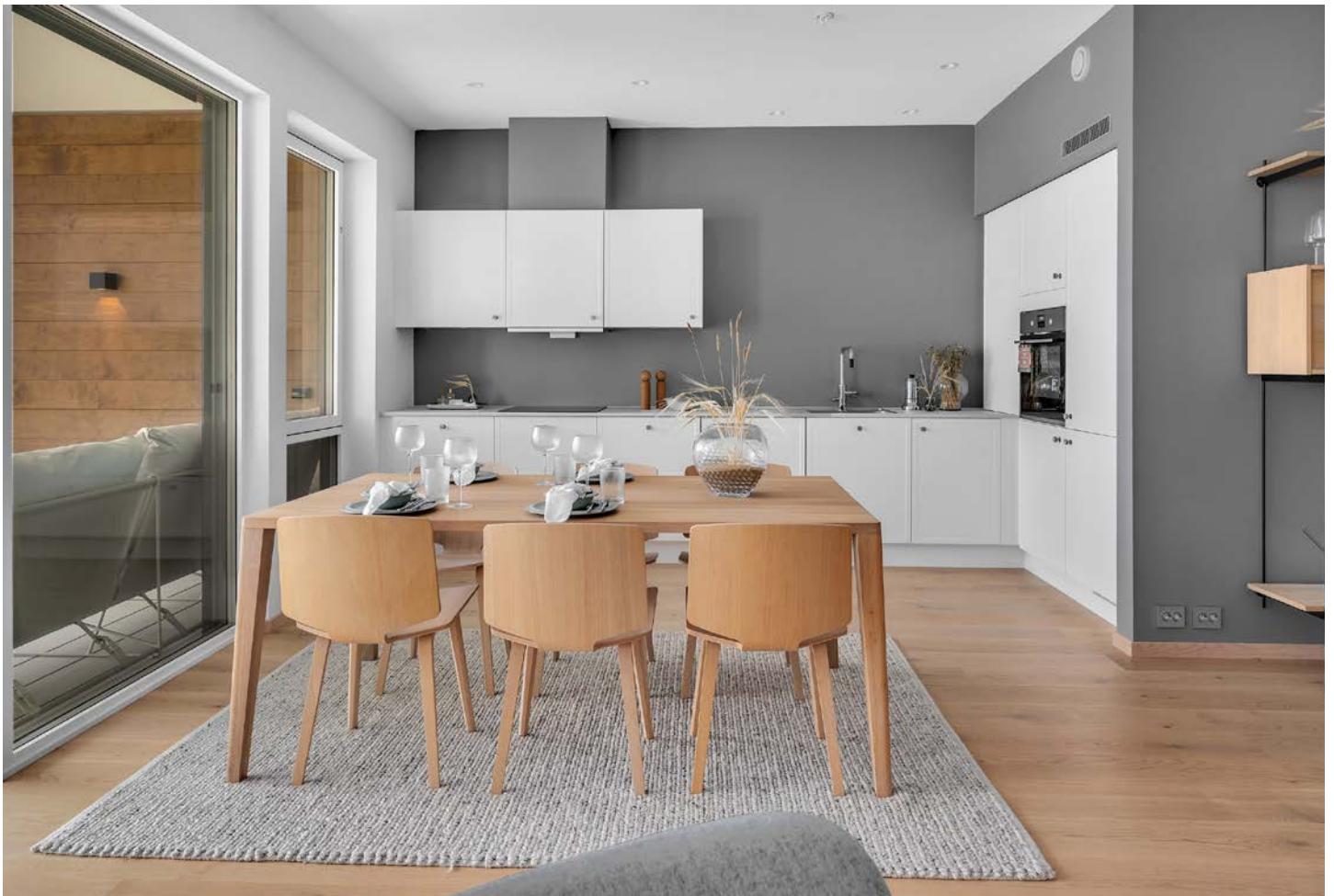
Vannbåren varme i gulv
