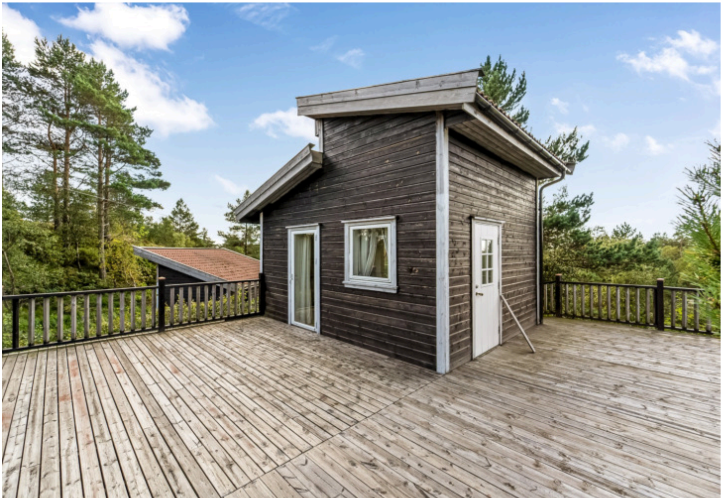
Bygg 2 - innredet med stue/soverom og bod.
