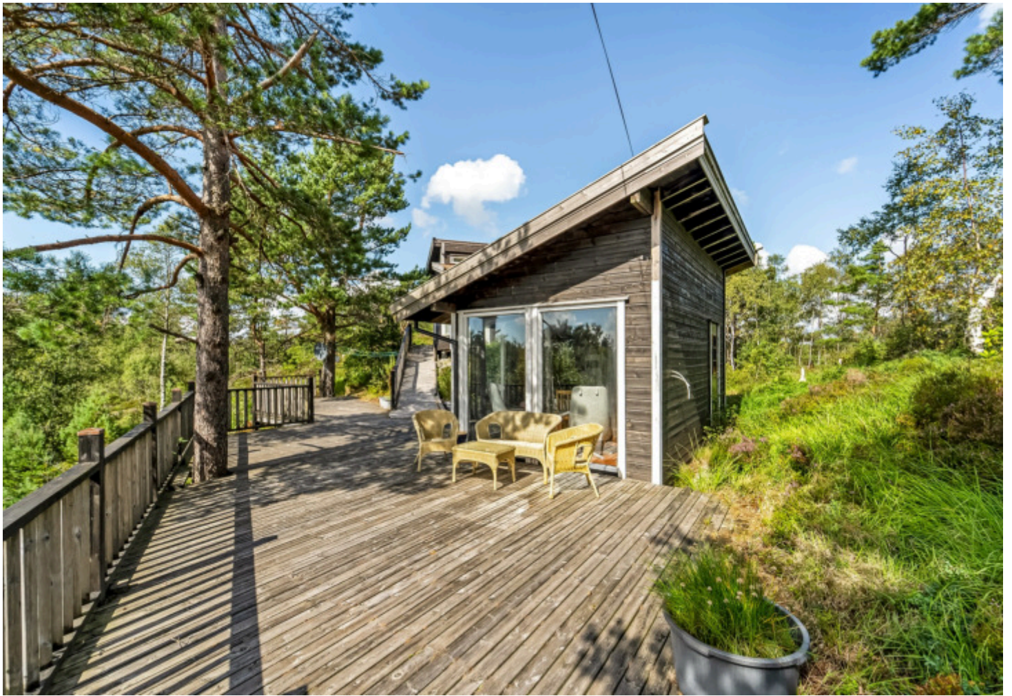
Bygg 1 - innredet med stue/kjøkken.
