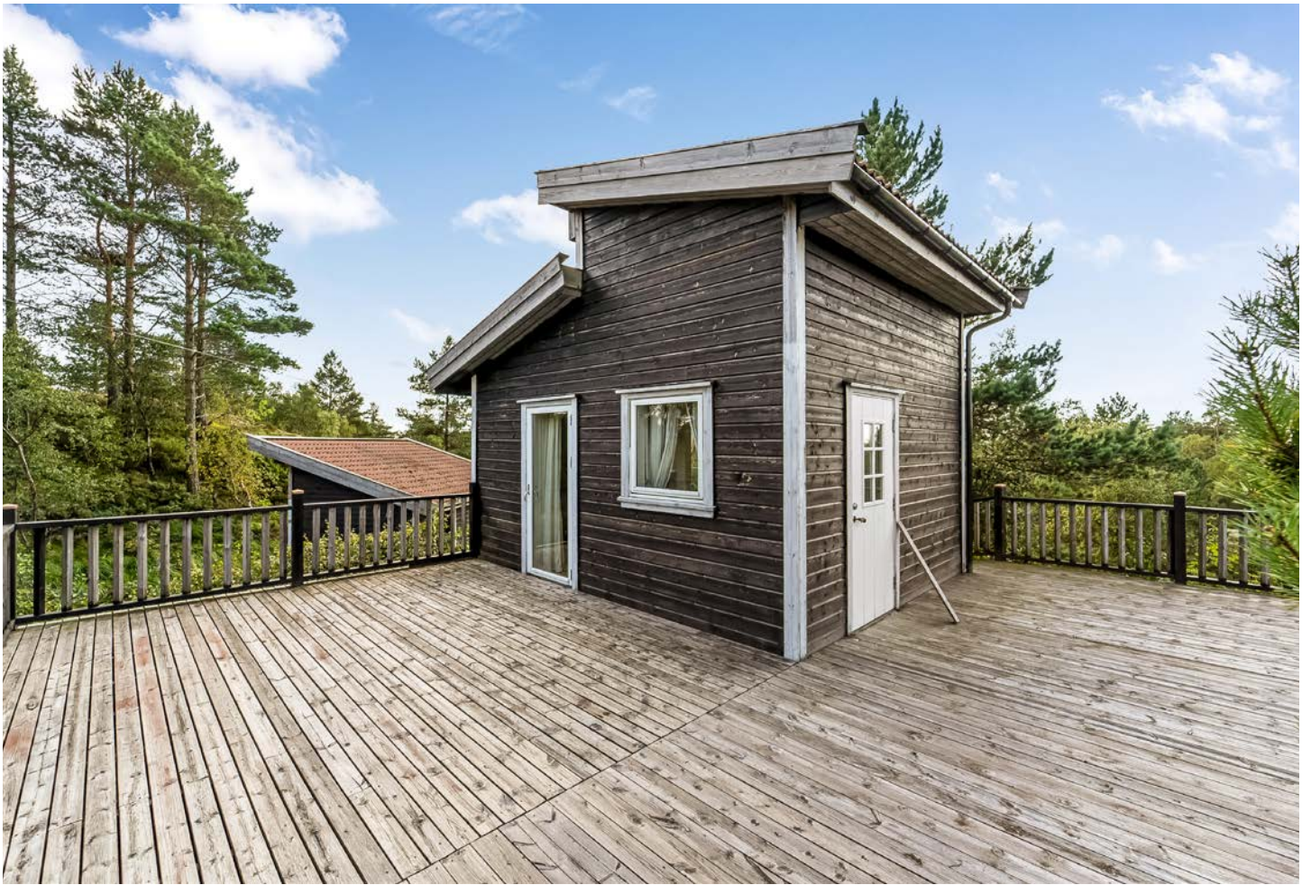
Bygg 2 - innredet med stue/soverom og bod.
