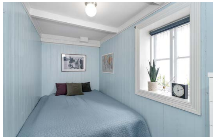
Rom i 1. etg innredet som soverom - iflg takstmann er rømningsvei ivaretatt, men det er for lite dagslysflate for godkjenning
