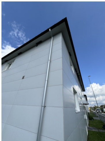
Hele fasader og lufting av tak/loft i gesims.
