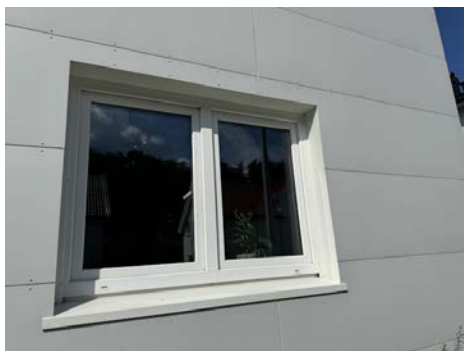
Vindu og tetting av beslag.
