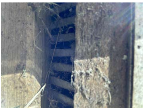
Lufting av kledning med montert musebånd.
