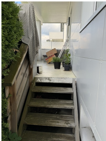
Trapp og rekkverk i tre.
