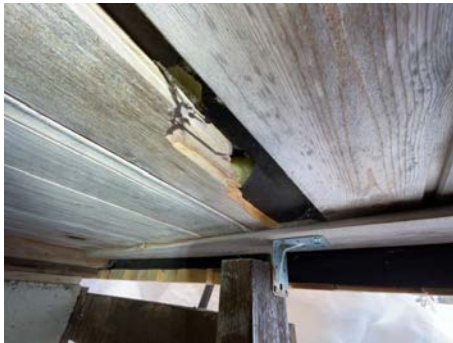
Bilde viser eksempel på åpning i stubbelofter på undersiden av bjelkelag.
