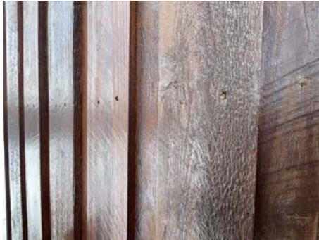
Bilde viser spiker som er dykket lengre inn i kledning enn anbefalt
