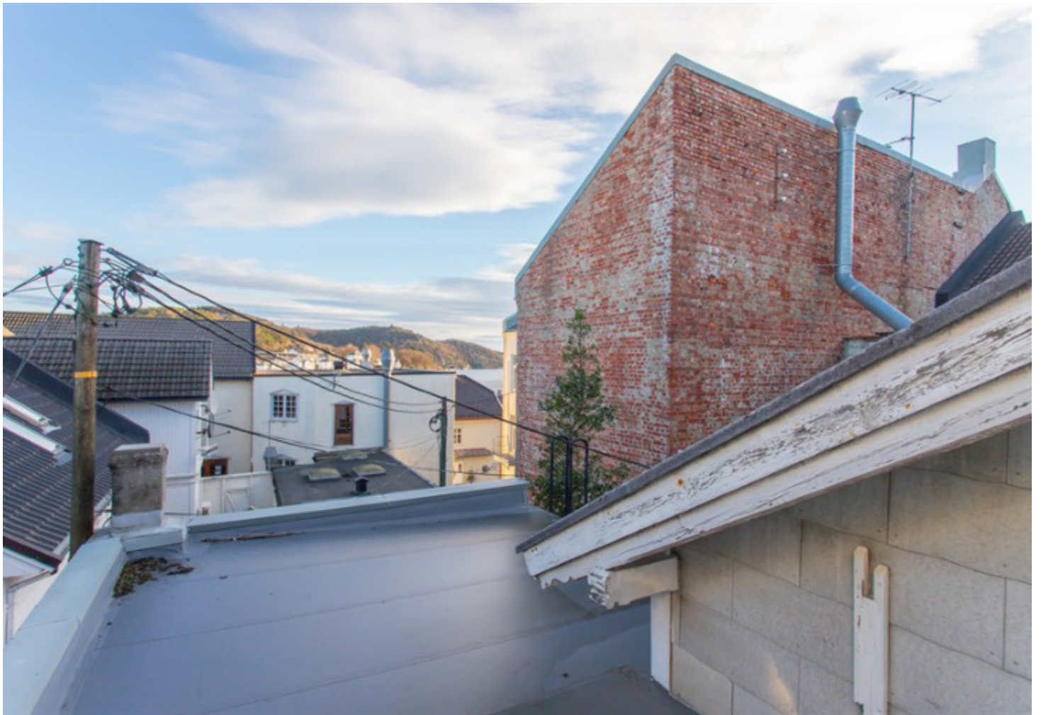
Takterrasse med adskomt fra loft. Terrassen er ikke tilstrekkelig sikret for bruk som terrasse.
